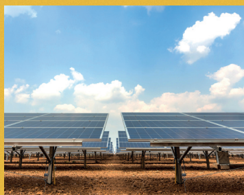
BODENMONTIERTE PV- ANLAGEN MIT FESTEM NEIGUNGSWINKEL
